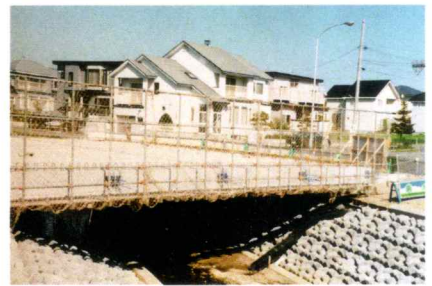
中野川6号橋新設工事
